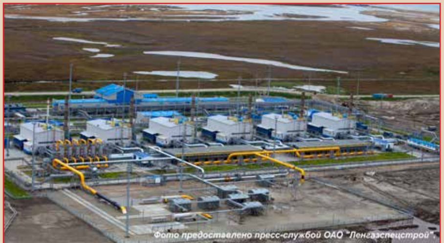
Фото 1. Применение материалов ВМП для антикоррозионной защиты металлоконструкций компрессорной станции «Байдарацкая» газопровода «Бованенково – Ухта», 2009–2011 гг. Система покрытия ЦИНОТАН + ПОЛИТОН-УР + ПОЛИТОН-УР (УФ)
