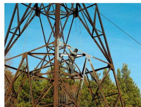
б) нанесение антикоррозионного покрытия
