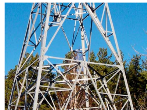
в) готовое покрытие ИЗОЛЭП®-mastic
