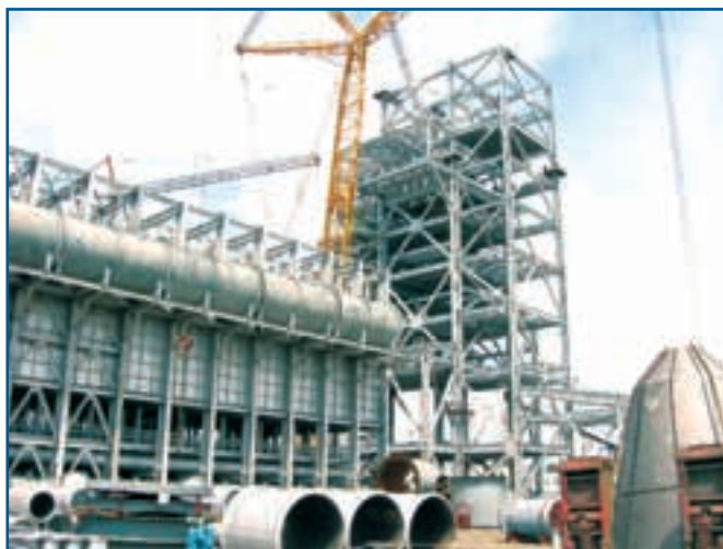
ОАО «Лебединский ГОК», металлоконструкции цеха горячего брикетирования железа
