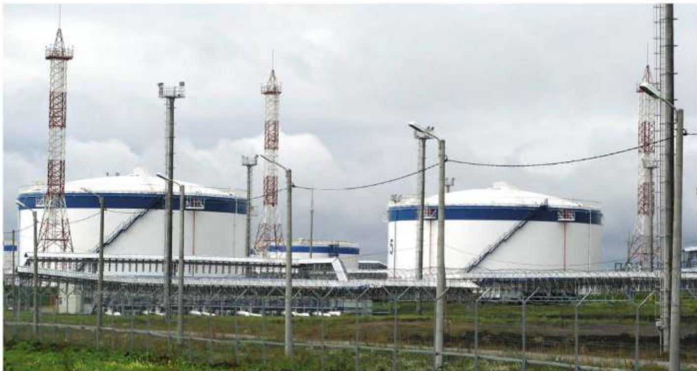
Резервуары для хранения нефти Уярского нефтеналивного терминала, ЦИНОТАН + ПОЛИТОН-УР + ПЛИТОН-УР(УФ)
