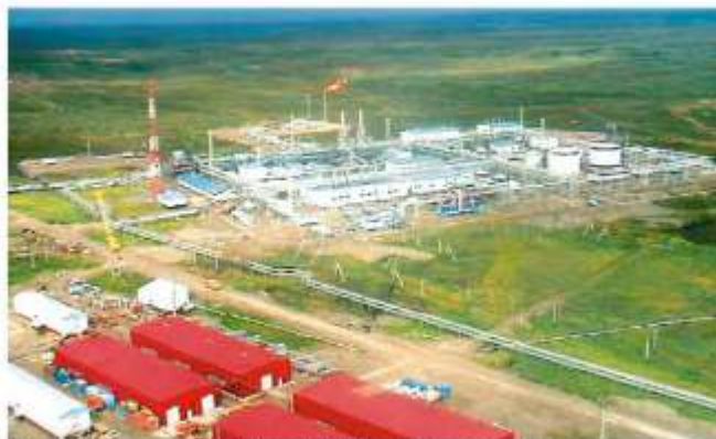
Металлоконструкции ЦПС Южно-Шалкинского месторождения, ЦИНОТАН + ПОЛИТОН-УР.
