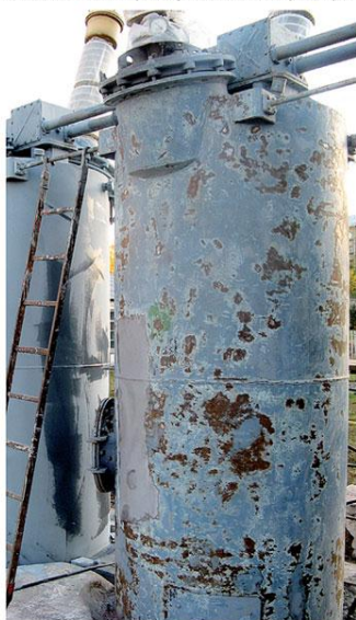
Рис. 1 б) поверхность, подготовленная к нанесению покрытия
