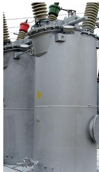
Рис. 1 в) готовое покрытие ИЗОЛЭП®-mastic
