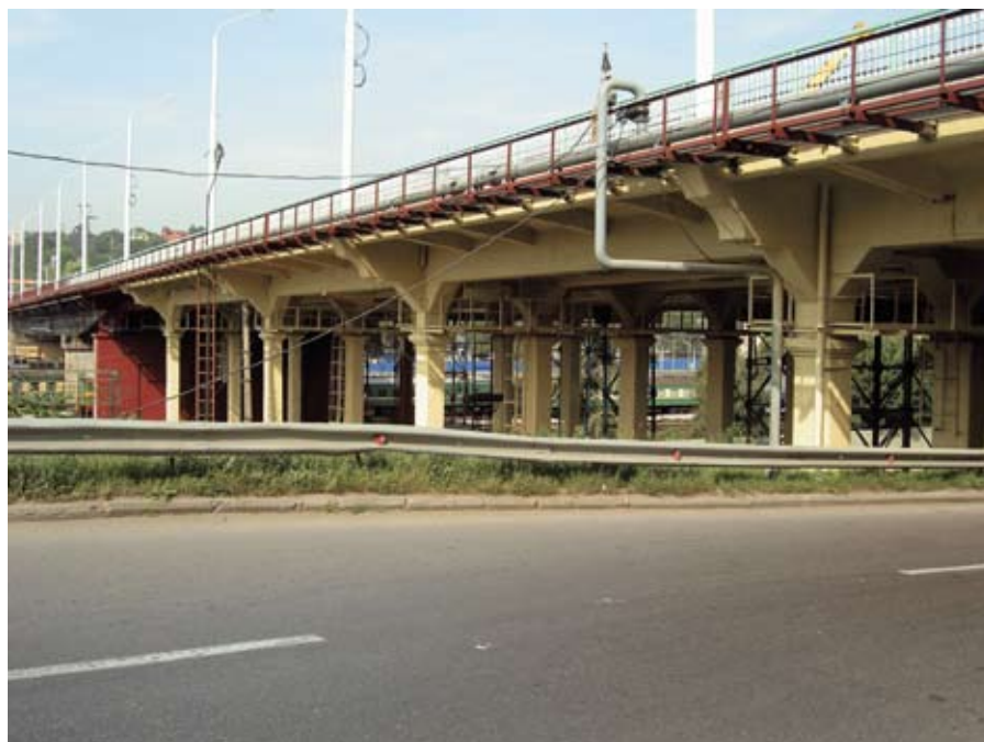
Рис. 5. Мост-путепровод на проспекте Стачки в г. Ростов-на-Дону. Ремонт бетонных конструкций проведен с применением полиуретановых покрытий ВМП
