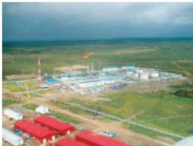
Металлоконструкции ЦПС Южно-Шапкинское месторождения, 2002–2004 г.г. Покрытие ЦИНОТАН+ПОЛИТОН-УР
