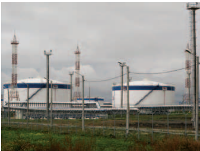
Резервуары для хранения нефти Уярского нефтеналивного терминала, 2006 г. Покрытие ЦИНОТАН+ПОЛИТОН-УР+ПОЛИТОН-УР(УФ)
