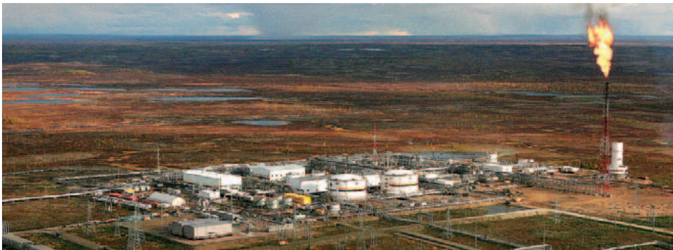
Металлоконструкции ЦПС, модульные здания Ванкорского нефтегазового месторождения, 2009–2010 г.г. Покрытие ЦИНОЛ+АЛПОЛ, ЦИНОТАН+ПОЛИТОН-УР+ПОЛИТОН-УР(УФ), ПЛАМКОР-2
