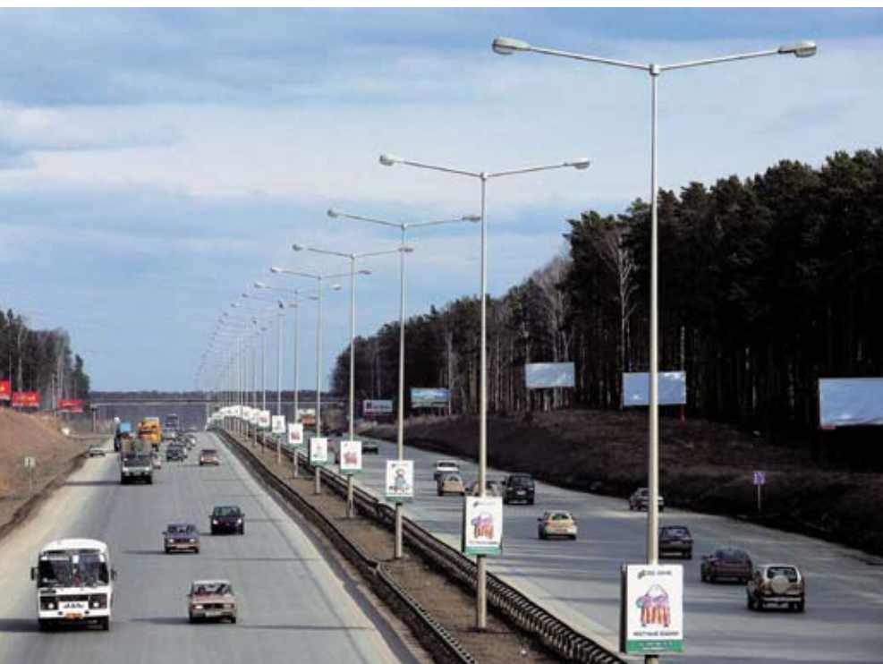
Фото 2. Осветительные мачты на трассе Екатеринбург-Кольцово
