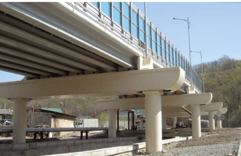
Фото 3. Мост вдоль реки Псахе в Сочи
